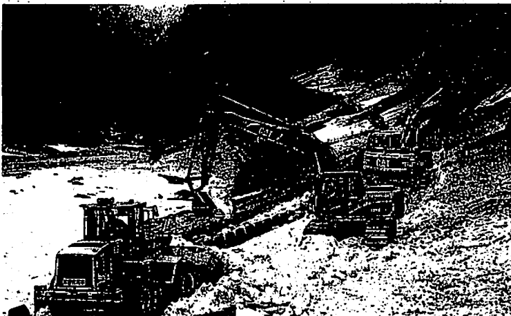
全線開通に向け、除雪が進む白山スーパー林道 中宮料金所付近 11月4日
